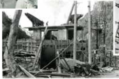
山麓駅舎建設中↓
